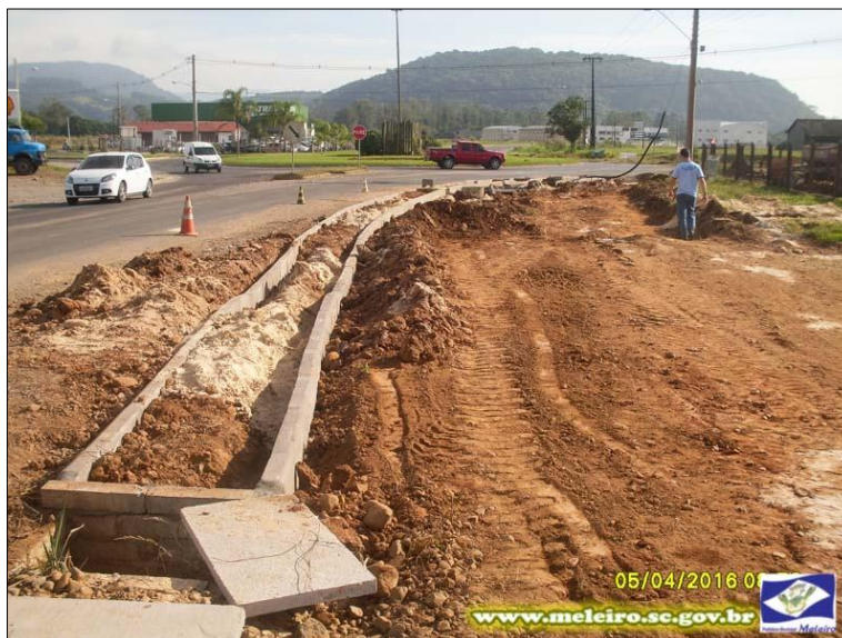
Foto 14 - Execução da obra de drenagem pluvial, construção de calçada e ciclovia. Fonte: site da Prefeitura de Meleiro, 2021.
