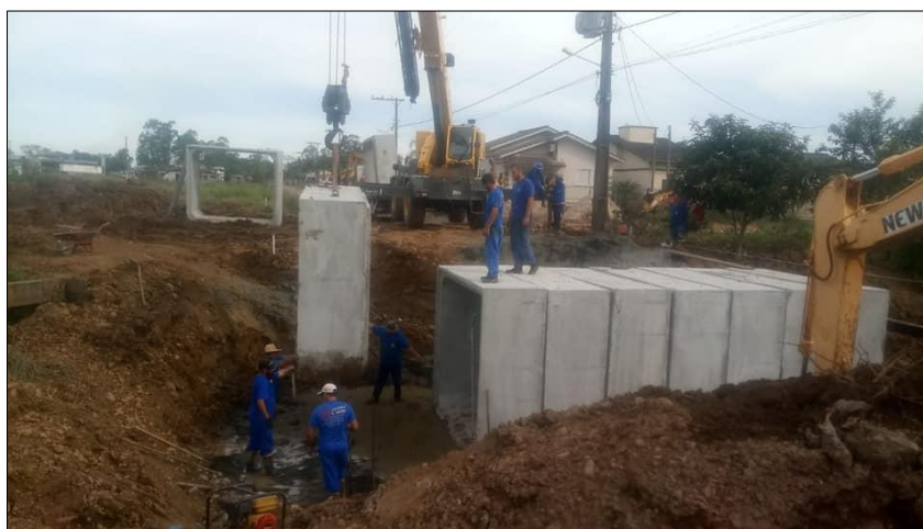
Foto 15 - Execução da obra de drenagem pluvial com galerias de concreto. Fonte: site da Prefeitura de Meleiro, 2021.
