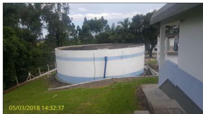
Foto 5 - Um dos reservatórios localizados junto à ETA.
