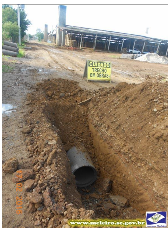
Foto 13 - Obra de pavimentação e drenagem pluvial em Barra do Cedro. Fonte: site da Prefeitura de Meleiro, 2021.
