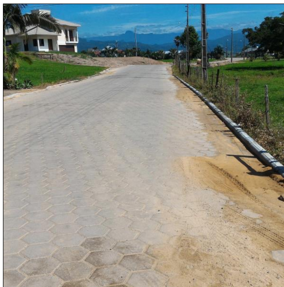
Foto 12 - Obra executada na comunidade de Novo Paraíso. Fonte: site da Prefeitura de Meleiro, 2021.
