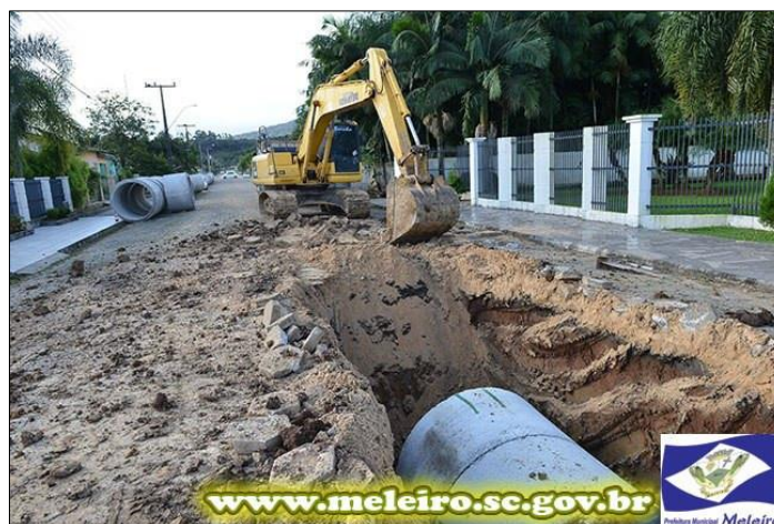
Foto 11 - Execução das obras de drenagem pluvial no Bairro Jardim Itália.
